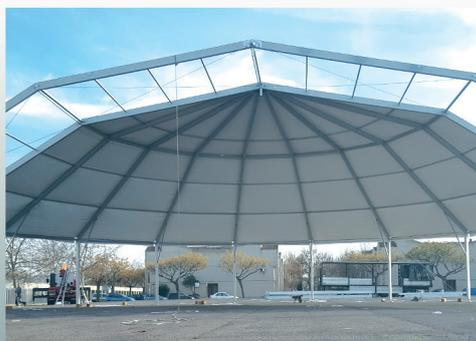
*Permite montaje de círculo completo, semicírculo y en óvalo añadiendo módulos de 5 en 5 metros.*
